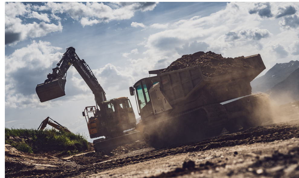
Viele Arbeiten wurden diesen Sommer in Angriff genommen. Hier am neuen Speichersee.
